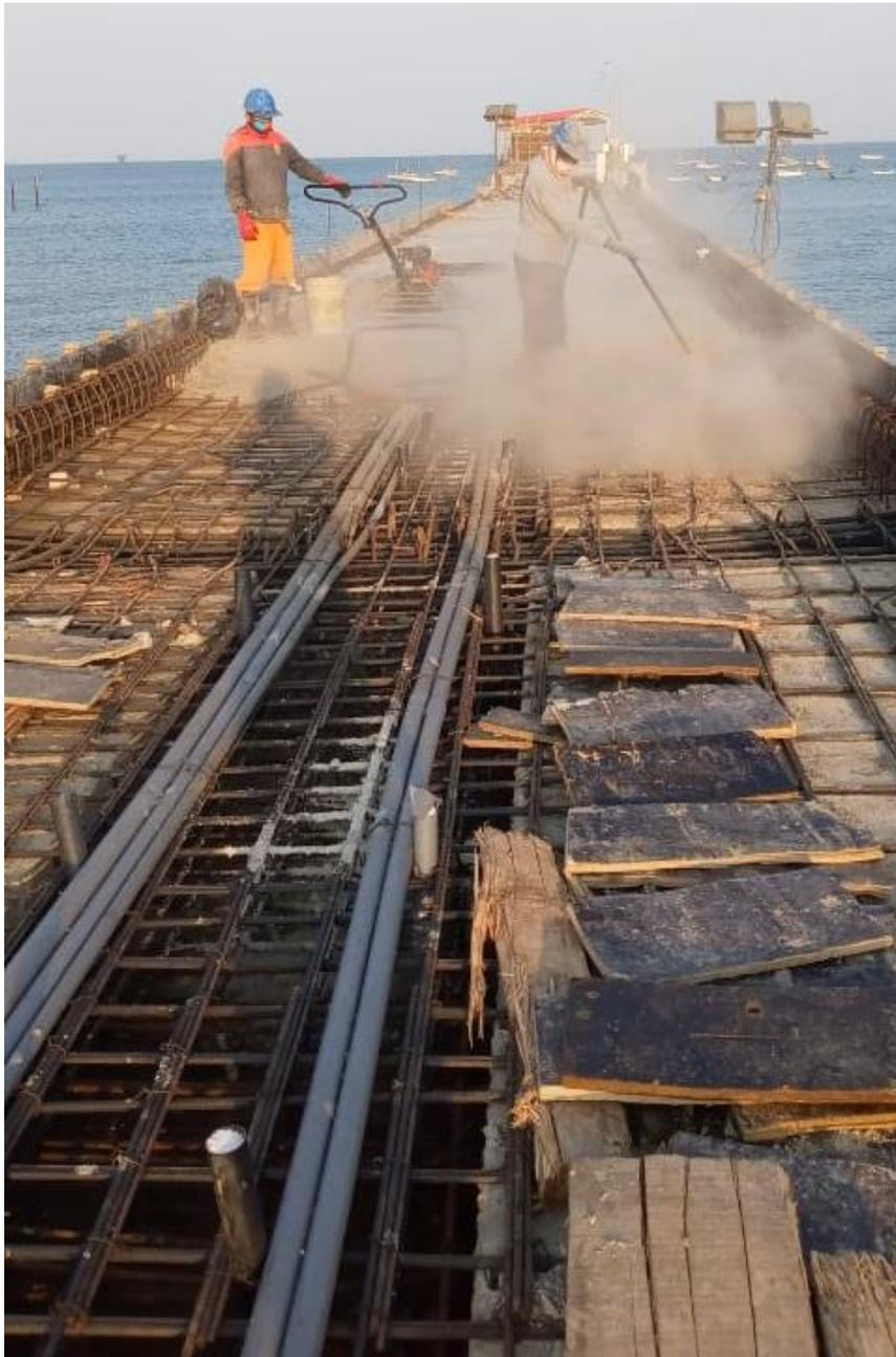
LIMPIEZA DE ACERO CON AIRE COMPRIMIDO PREVIO AL ENMALLADO Y VACIADO
